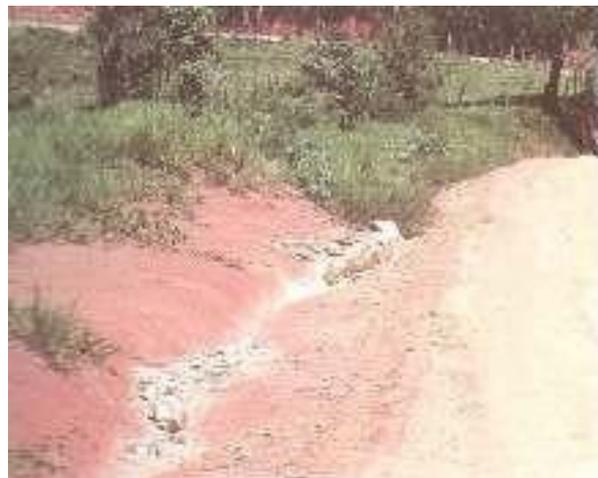
Figura 28: pedras ao longo da sarjeta agindo como dissipadores de energia (Fonte: Ken Skorseth, 2000)
