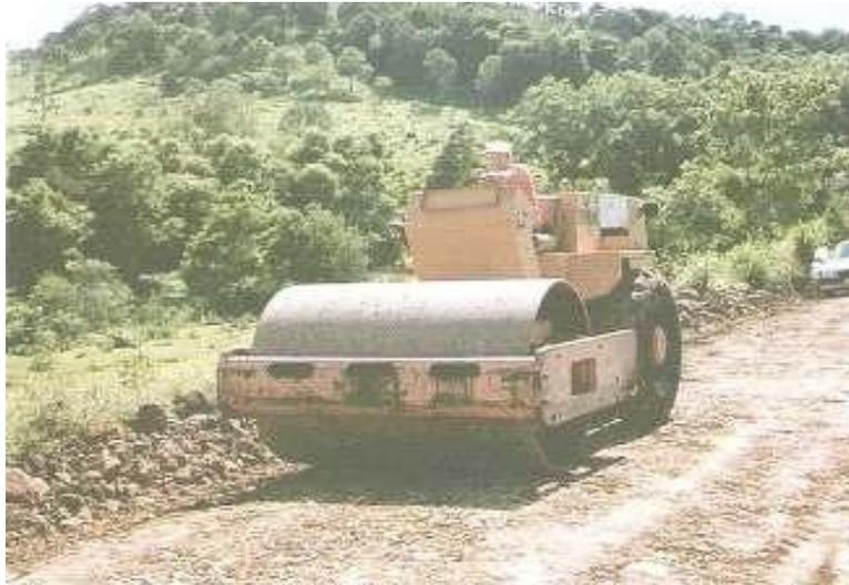
Figura 39: Rolo compactador atuando no revestimento
