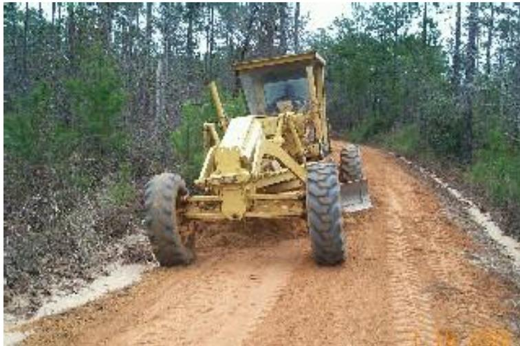
Figura 23: motoniveladoras podem criar e fazer a manutenção dos bigodes de forma bastante simples (Fonte: Ken Skorseth, 2000)
