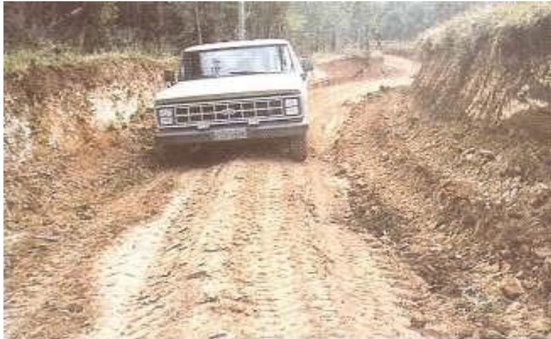
Figura 2: seção transversal imprópria (Fonte: Baesso e Gonçalves, 2003).
