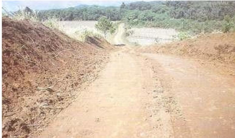
Figura 8: perda de agregados (Fonte: Baesso e Gonçalves, 2003)
