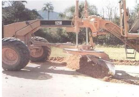
Figura 49: posição da lâmina para mistura de materiais (Fonte: Baesso e Gonçalves, 2003)
