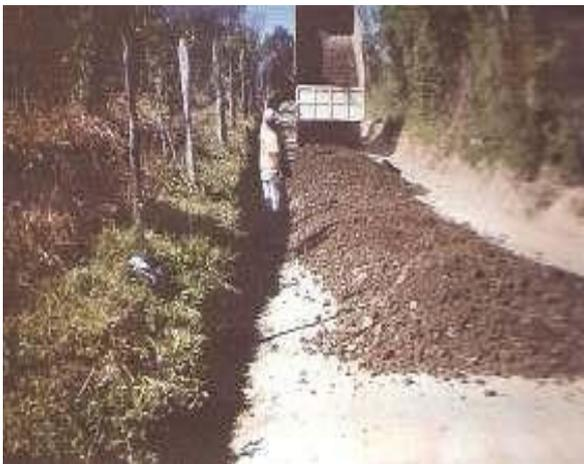
Figura 32: caminhão basculante despejando material ao longo do trajeto
