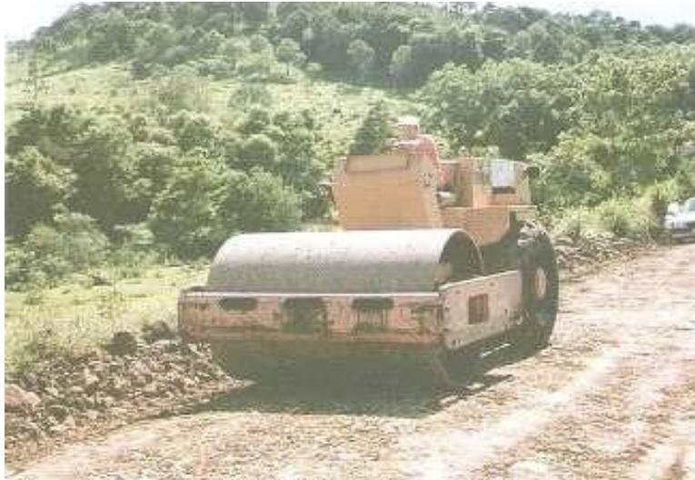
Figura 39: Rolo compactador atuando no revestimento
