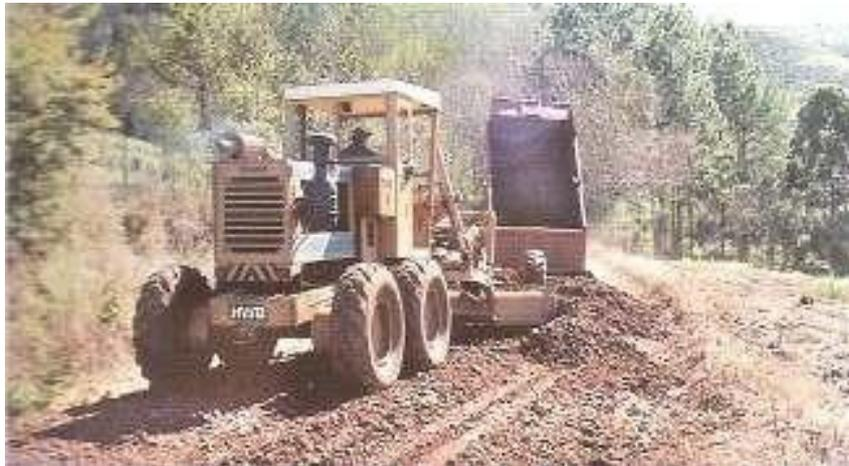
Figura 35: caminhão basculante despejando material para revestimento e a motoniveladora espalhando
