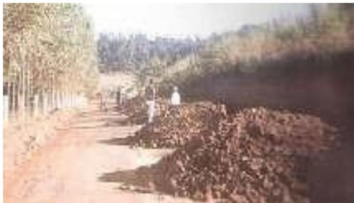
Figura 34: pilhas de basalto alterado para ser utilizado como camada de revestimento.
