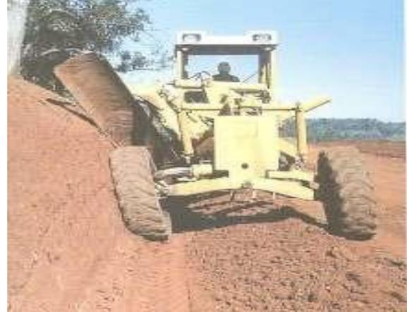
Figura 56: motoniveladora reconformando talude (Fonte: Ken Skorseth, 2000)
