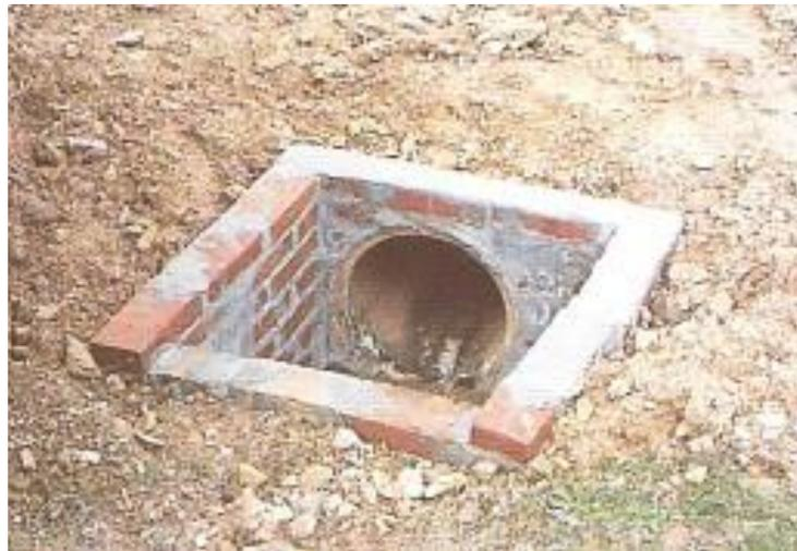
Figura 30: caixa coletora feita com tijolos, argamassa e os tubos são de concreto
