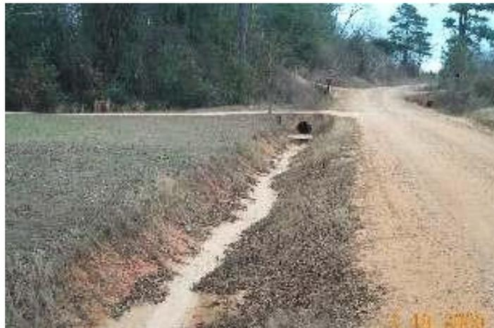
Figura 16: exemplo de uma sarjeta em ótimo estado (Fonte: Ken Skorseth, 2000)
