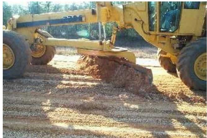
Figura 47: posição da lâmina de corte
