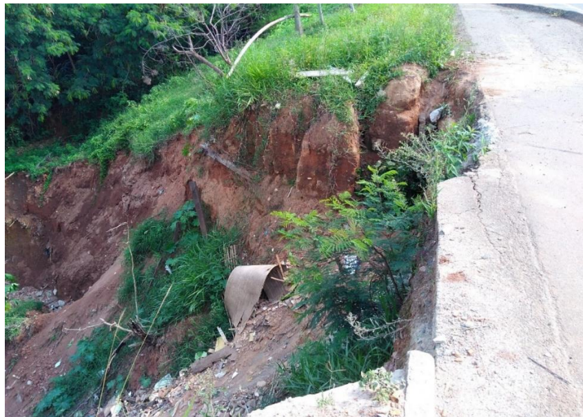
Figura 7: Av. Lincoln Westing – Erosão devido a adutora aberta.
