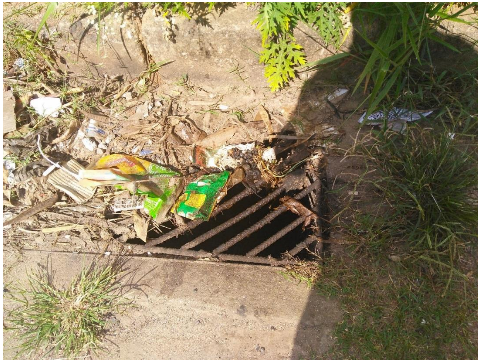
Figura 8: Bocas de Lobo sem manutenção
